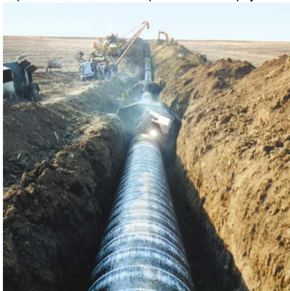
Рис. 6 Сварка целлюлозными электродами в строительстве трубопроводов
