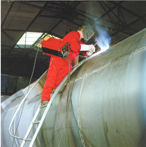
Рис. 21 Применение ручной сварки стержневыми электродами в изготовлении резервуаров
