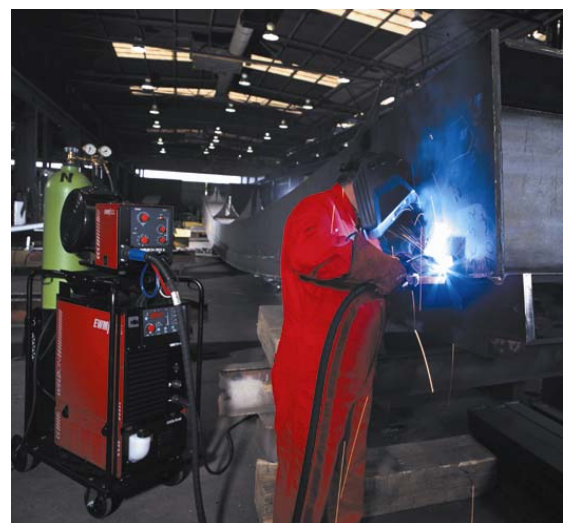
Рис. 38 Сварка МАГ несущих балок в строительстве стальных конструкций
