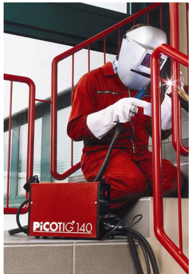
Рис. 4 Сварка ВИГ поручня
