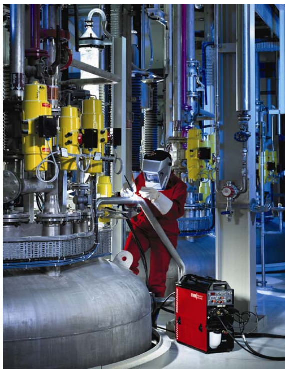
Рис. 30 TRITON 260 DC, сварка ВИГ трубопроводов
